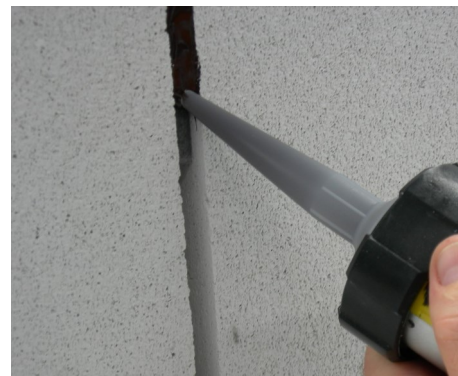
Obr. 2: Dilatačná škára v zvislej konštrukcii
