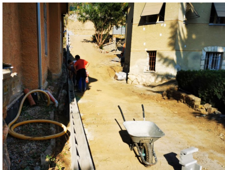
Obr. 6: Oplotenie pri východnej strane domu
