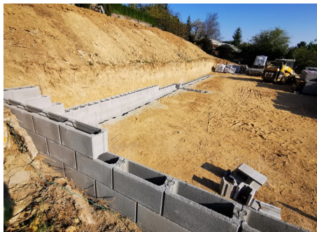
Obr. 5: Oplotenie (severná časť) – v mieste budúceho skleníka
