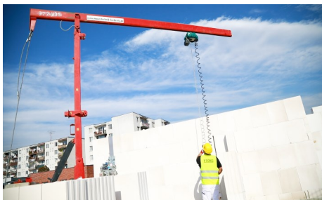
Obr. 2: Stavebná mechanizácia – minižeriav
